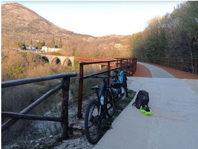
Lauria, ponte di ferro
