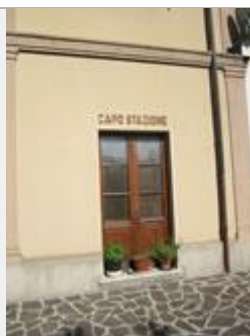
Particolare dell'ingresso dell'ufficio del capostazione della ex-stazione di Fossato di Vico (FAC) (A. Stigliani, 2017)
