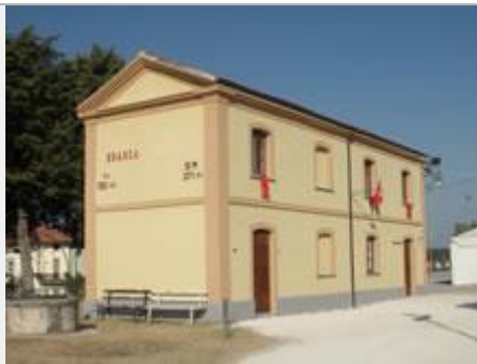
Ex-stazione di Branca, al km 125,385 da Arezzo, in ottimo stato di conservazione (R. Rovelli, 2012)
