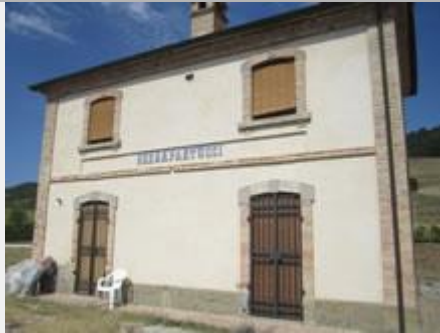
Ex-stazione di Serrapartucci, divenuta un'abitazione privata (A. Stigliani, 2017)
