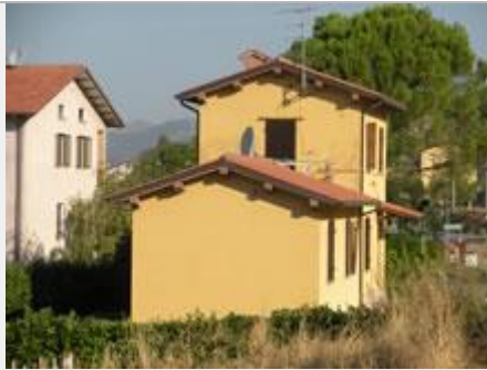
Ex-casello tra Torre Calzolari e Branca, trasformato in abitazione (R. Rovelli, 2012)
