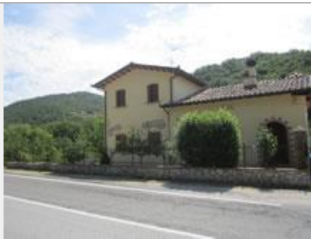
Ex-casello tra Serrapartucci e Campo Reggiano, ampliato e trasformato in abitazione (A. Stigliani, 2017)
