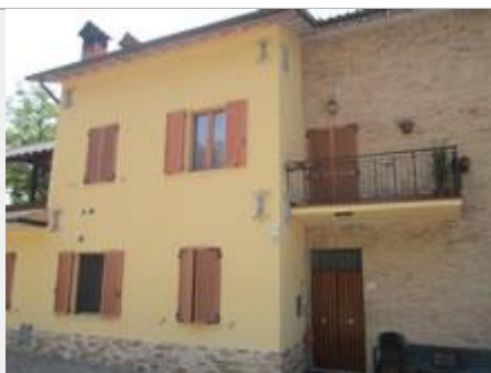
Fabbricato viaggiatori della ex-stazione di Pietralunga
